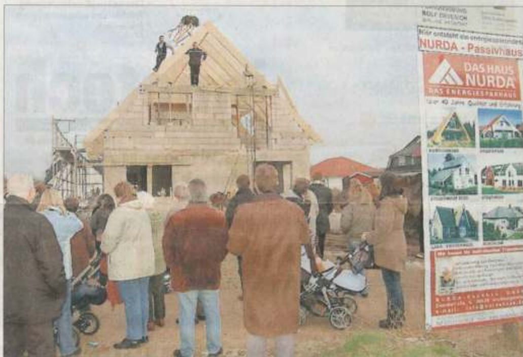
Eines der am Dienstag gerichteten Häuser: Man beachte die stark dimensionierten Dachsparren. Dazwischen kommt nur Isoliermaterial hinein. Foto: hhs
