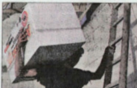
Bis zu 50 Zentimeter dick wird gedämmt.
