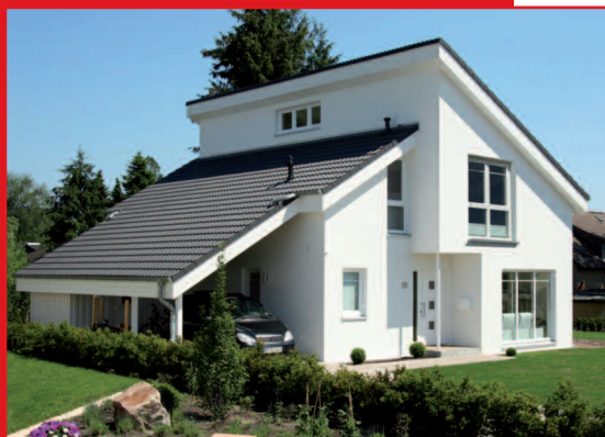
NURDA®-KfW-Effizienzhaus in Wettmar
