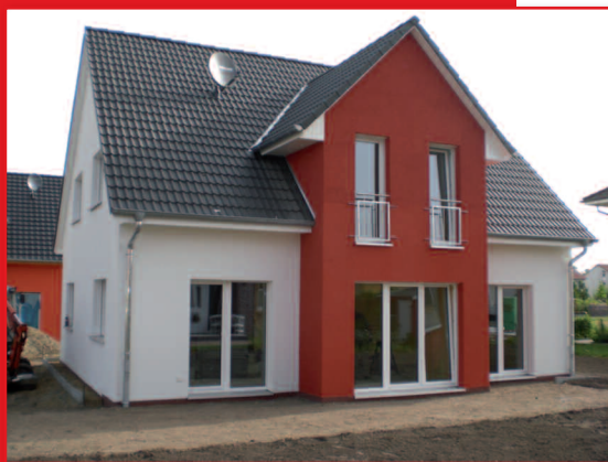
NURDA®-Passivhaus in Großburgwedel
